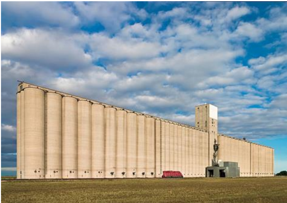
Figure 14 - Silos verticaux en béton
