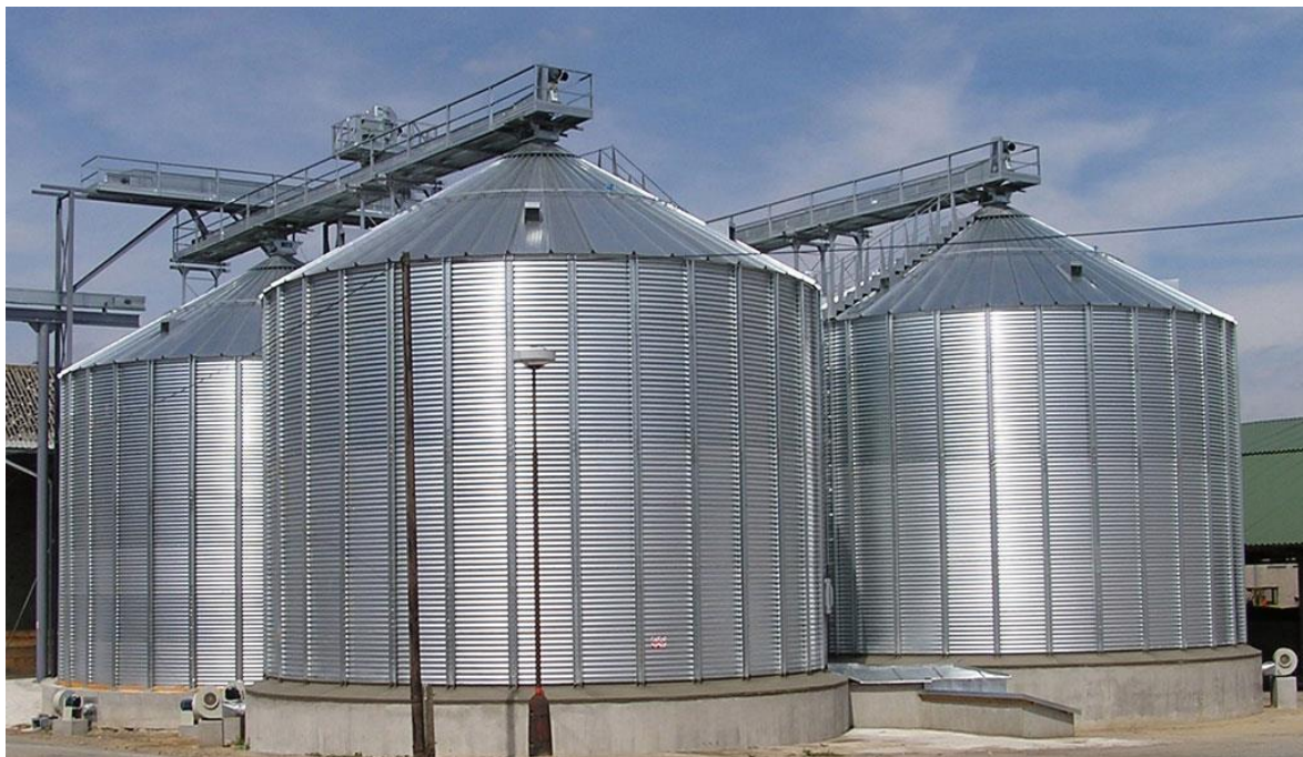
Figure 15 - Silos de stockage en métal à fond plat
