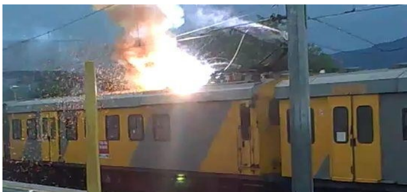
Figure 2.7 Explosion d'origine électrique
