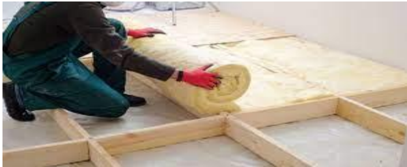
Figure 3.3 : la pose du polyuréthane
