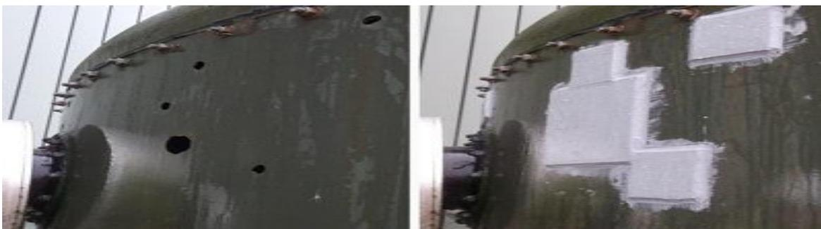
**Figure III.13:** photographie de réparation par patch
