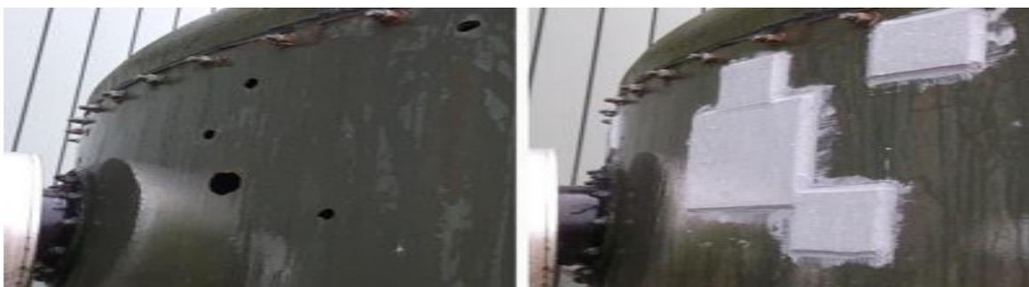
**Figure III.13:** photographie de réparation par patch
