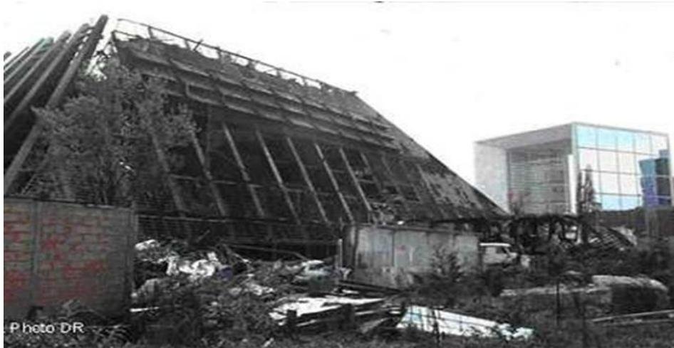
*Figure 50 : Explosion de la chaufferie*
