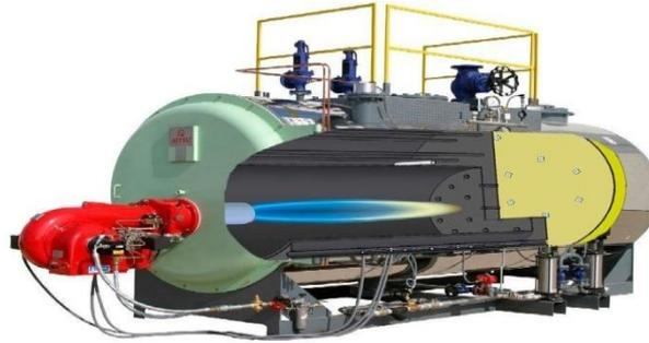
Figure 8 : Chaudière à tube de fumée
