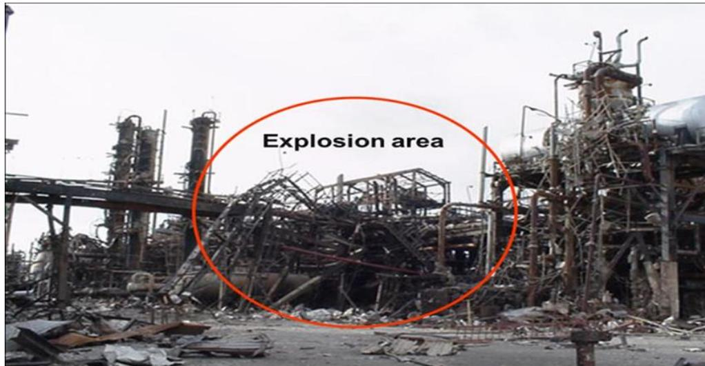
*Figure 48 : Explosion d'une chaudière de Raffinage Skikda*
