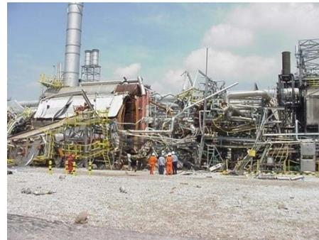
**Figure 31 : Explosions des générateurs à vapeur**
