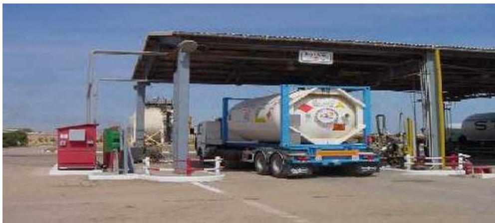
Figure II.10 : Chargement des camions.
