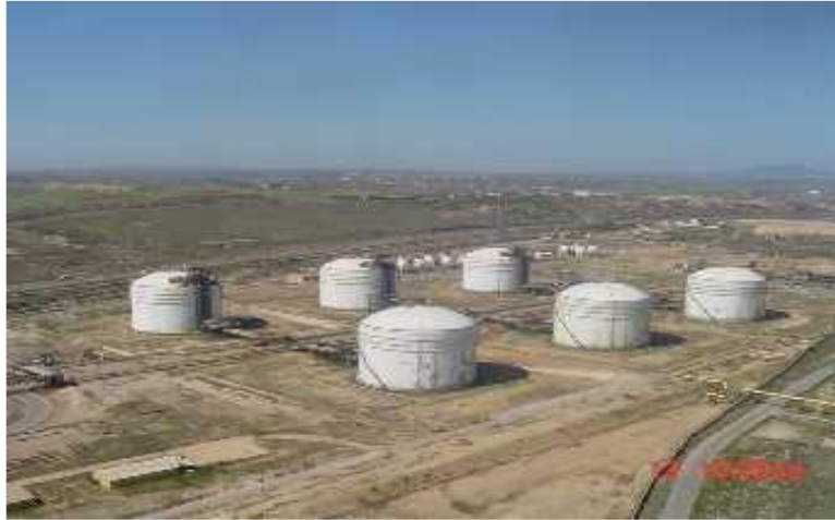
Figure II. 7 : Bacs de stockages de propane et butane réfrigérés.
