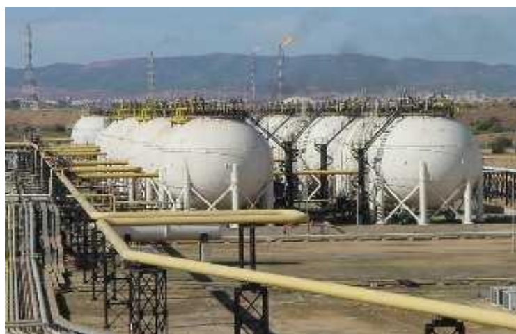
Figure II. 6 : Sphères de stockage de charge d'alimentation [7].
