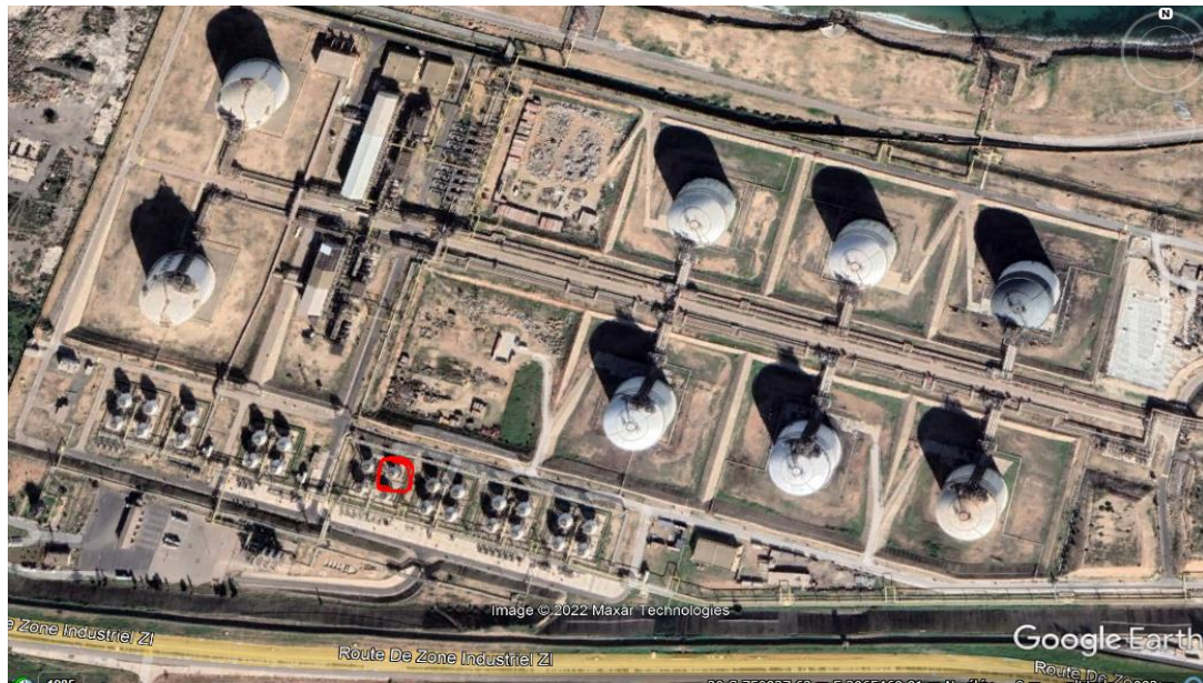
Figure 23: la sphère de stockage et Environnement avoisinant.
