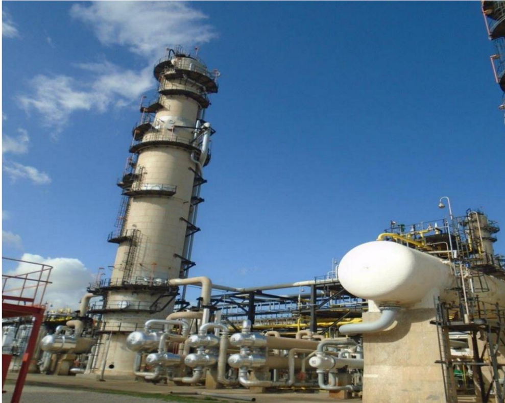
Figure 21: colonne de séparation (Fractionnateur)
