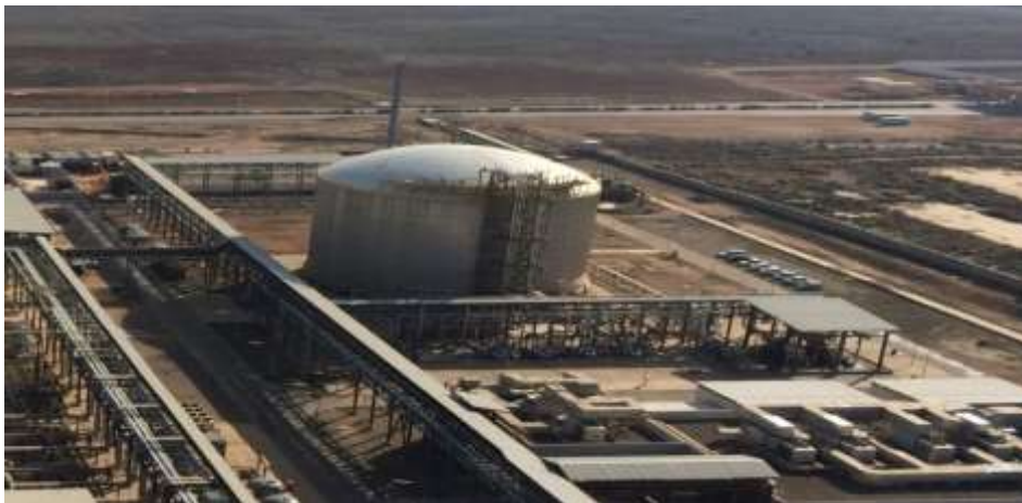
Figure 5.1 : bac de stockage du complexe SORFERT.
