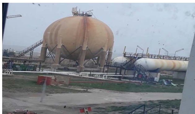
Figure 25 sphère et cigares de stockage de propane et butane au niveau de CE141
