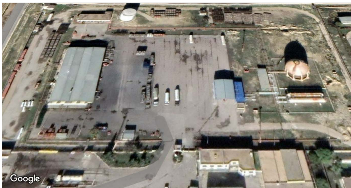
Figure 24 prise de vue aérienne du centre enfuteur CE141 NAFTAL TIARET
