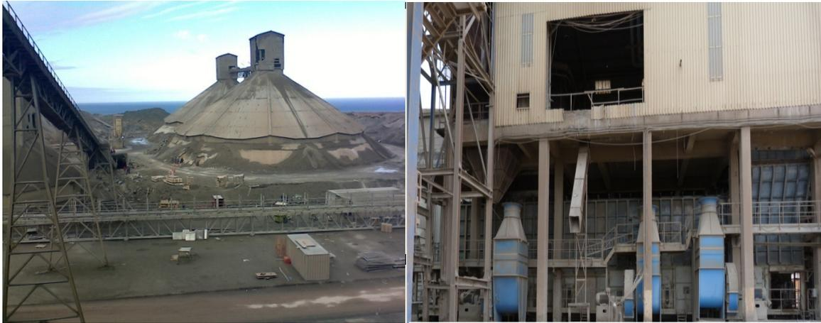
**Fig. IV.7 - Refroidissement et stockage du clinker.**
