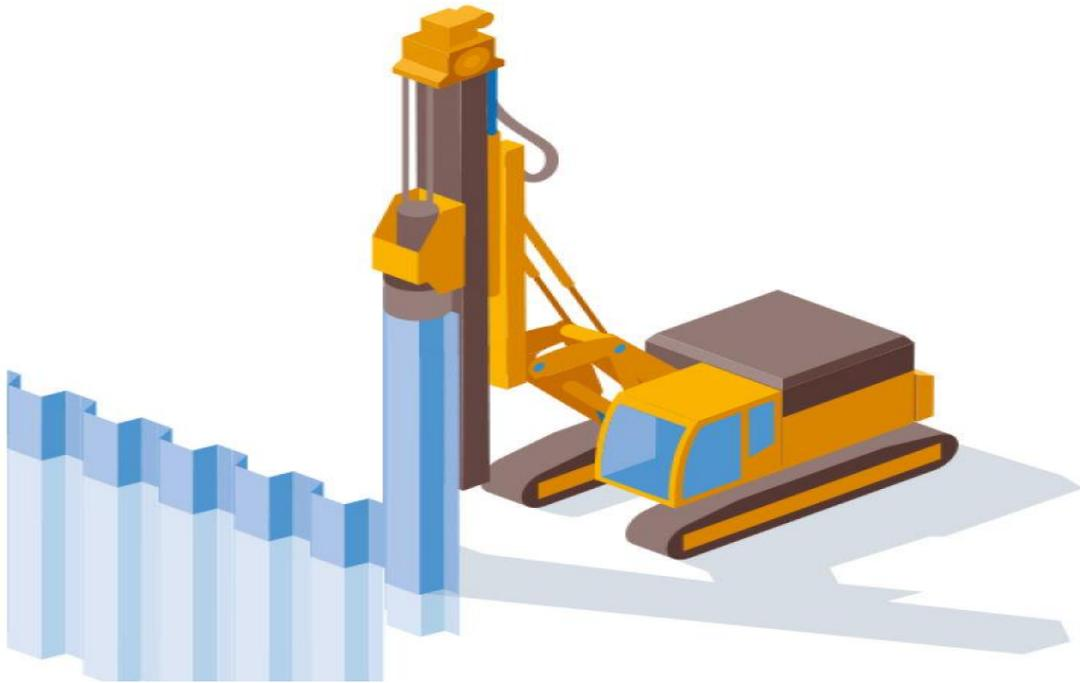
**Figure II.9.** La mise en œuvre de palplanches
