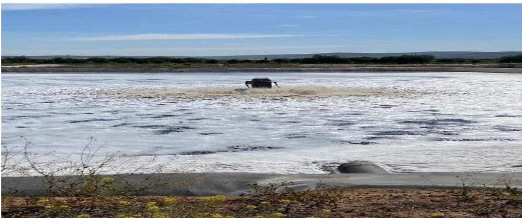
**Figure 1.11 :** Système de traitement par lagunage aéré.
