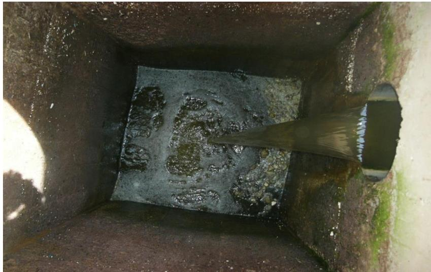
Figure 2.9 : Ouvrage de sortie des eaux épurées.
