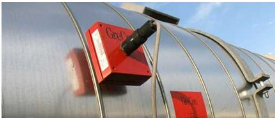
Figure III.4 : Système de détection et d'extinction d'étincelle "GreCon".
