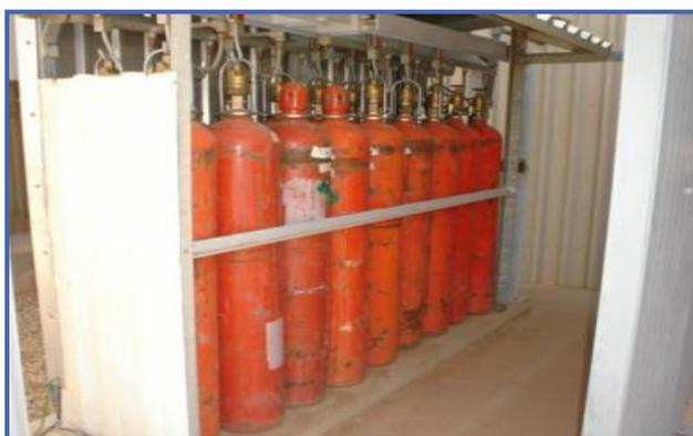
Figure 2.7: Racks bouteilles des compresseurs de gaz résiduel.
