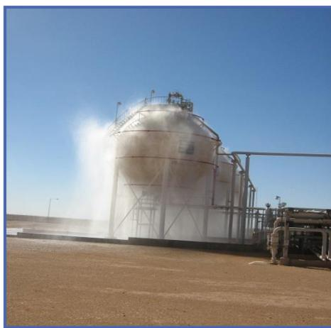
Figure 2.6 : Test des déluges au niveau des sphères.
