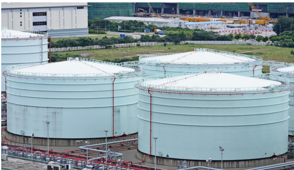
Figure 1 : Réservoir de stockage d'essence( site web 1 )
