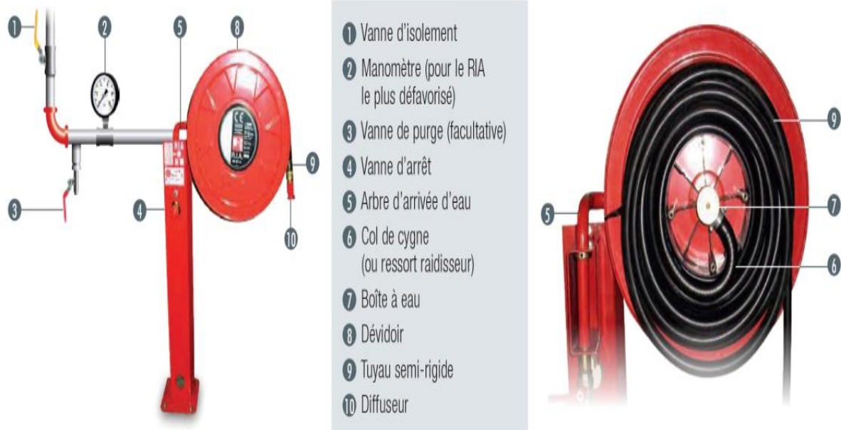
Figure 2.17 ; Les composants de R.I.A [4]
