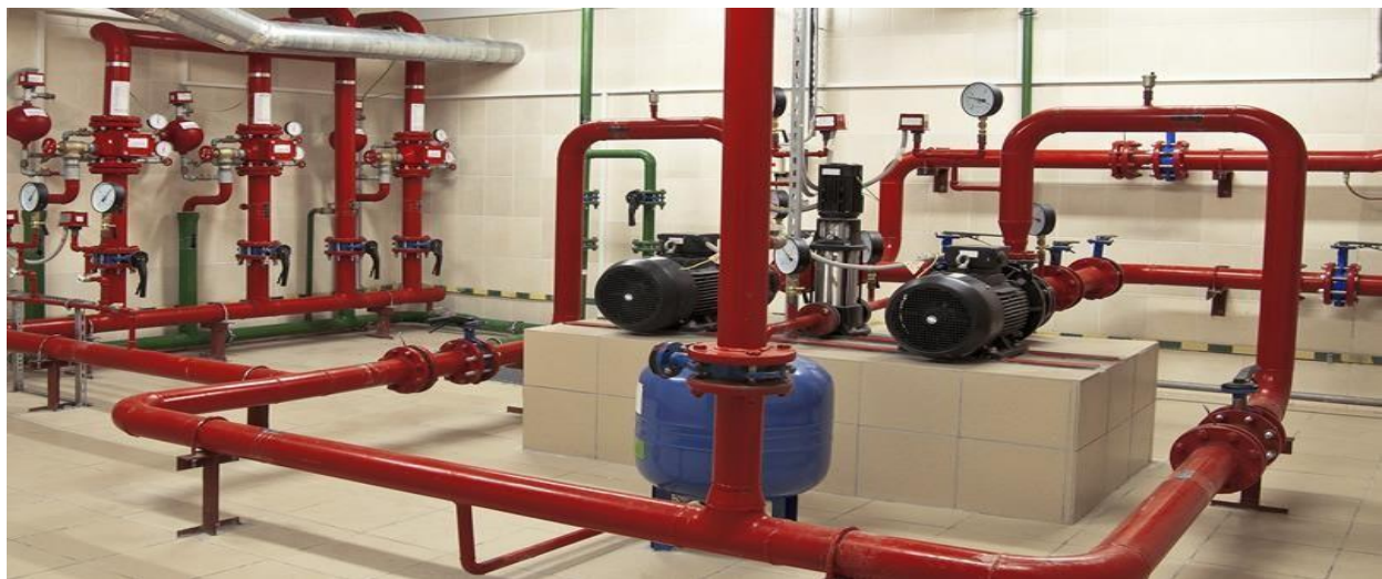
Figure 2.25 : Installation sprinkleur [32]
