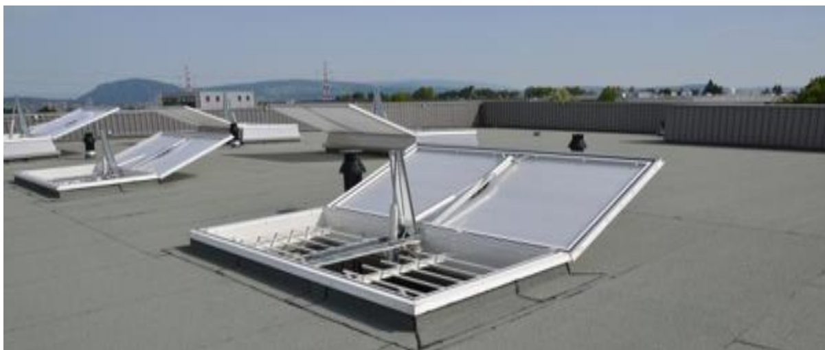
Figure 2.28 : Désenfumage naturel en toiture
