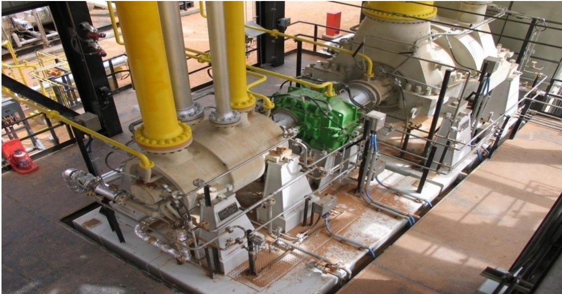
Figure III. 13: compresseur centrifuge à quatre étage [13]
