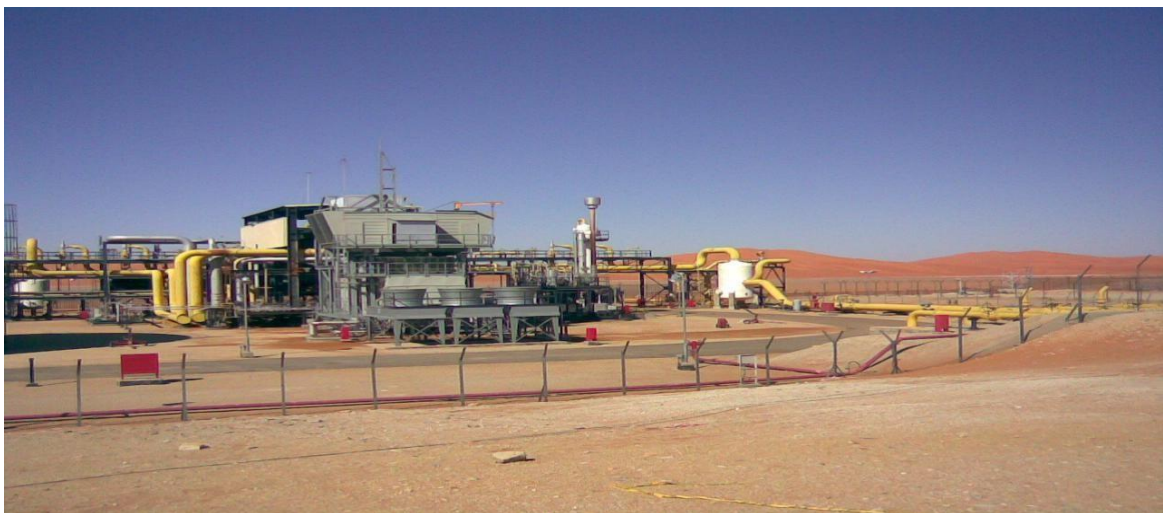
Figure III. 8: Vu général de site [13]
