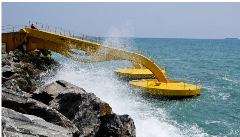
Fig. I. 14.b - Installation vague d'énergie.
