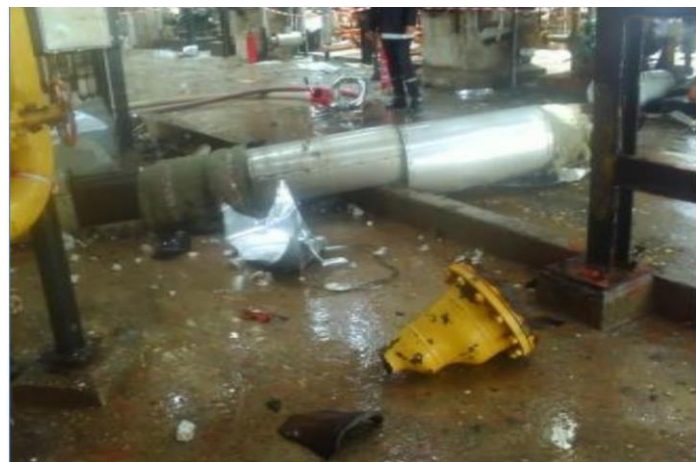
Figure I.6:Accidents survenus sur le complexe GL2Z
