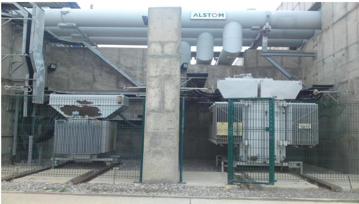
Figure 4.3 : Transformateurs Auxiliaire et de Démarrage du centrale Relizane
