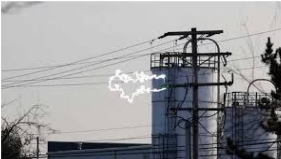
**Figure 2.2 : Arc électrique du câblage haute tension.**
