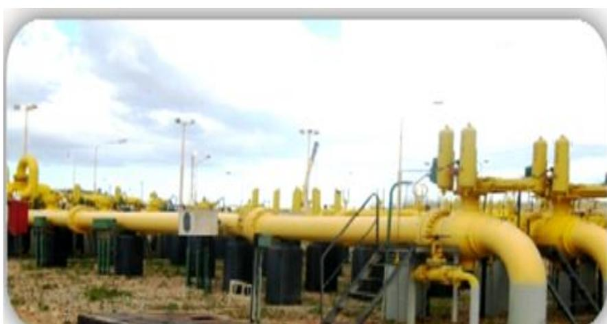
**Figure 24.** *Comptage GZ3(06 rampes de diamètre de 20).* [F21]
