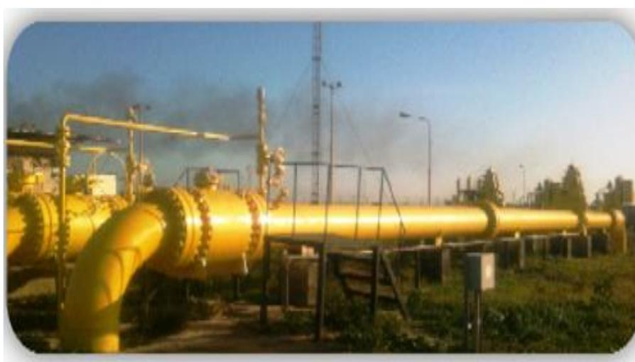
**Figure 25.** *Comptage GZ4 (02 rampes de diamètre de 24).* [F21]
