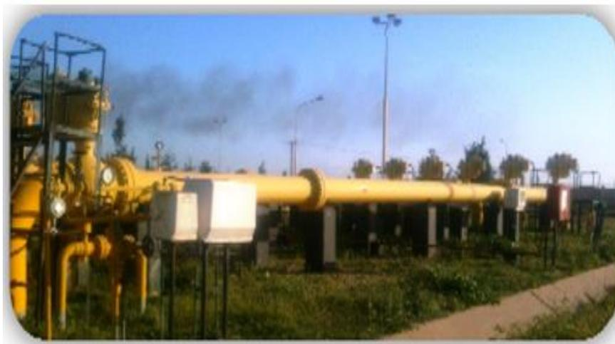
**Figure 23.** *Comptage GZ2 (06 rampes de diamètre de 20).* [F21]
