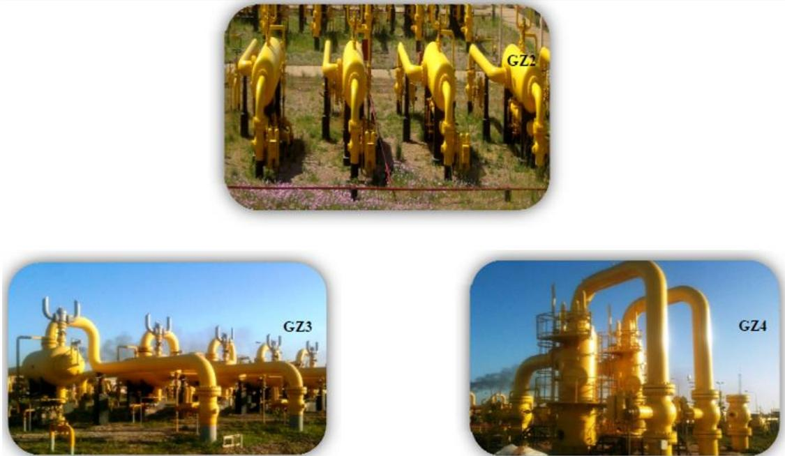
**Figure 21.** Les Filtres de la terminale arrivée. [F21]
