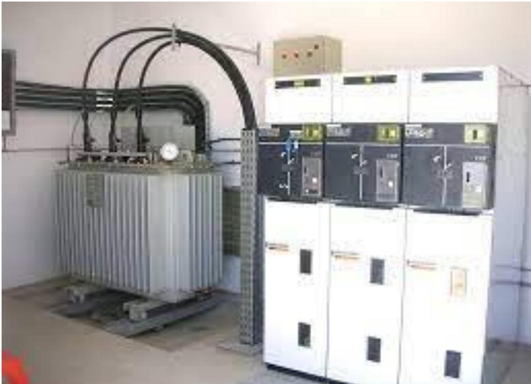
**Figure 1.8 : Cellules d'un poste MT/BT.**
