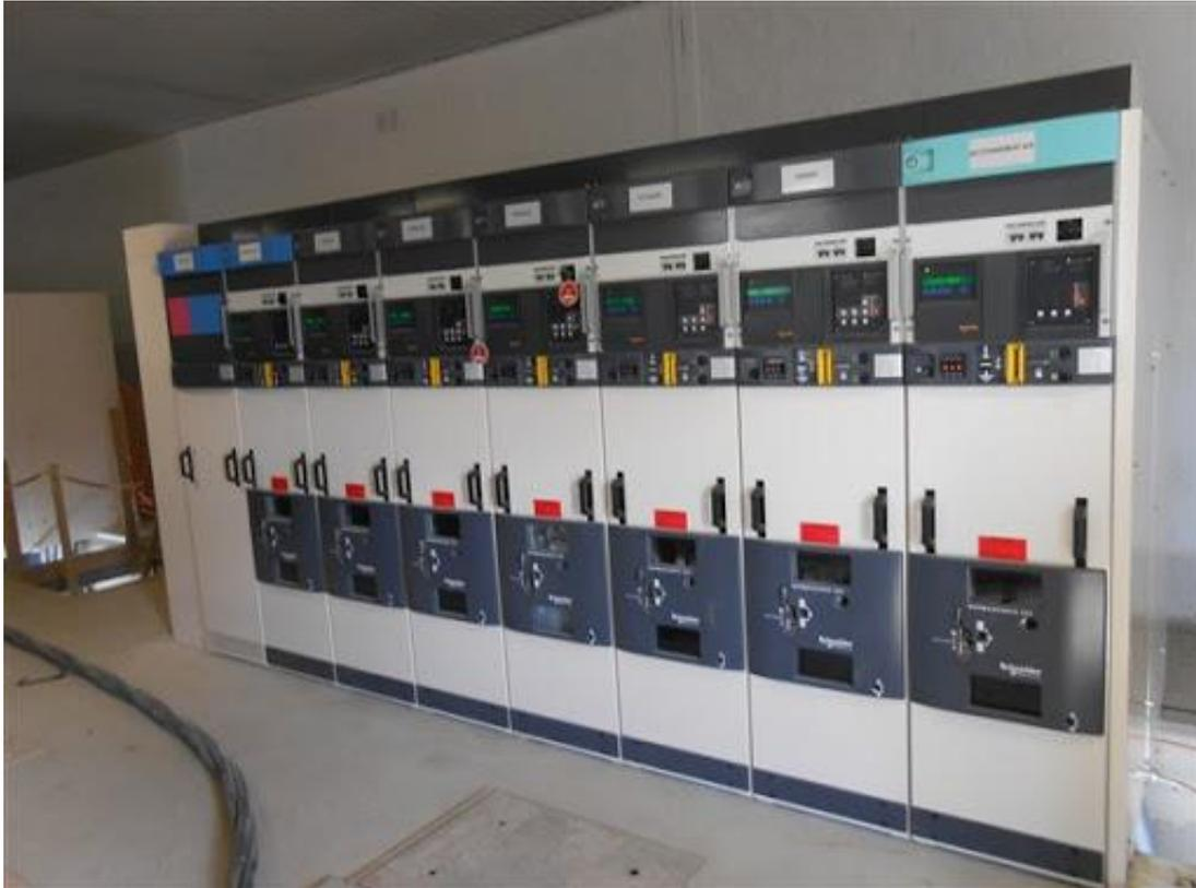
**Figure 1.7 : Cellules d'un Poste HT/MT.**
