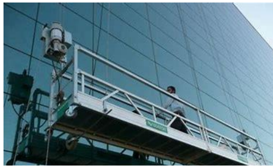
Figure 15.plateforme de travail suspendu
