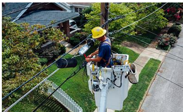
Figure 8.électricien travail en hauteur
