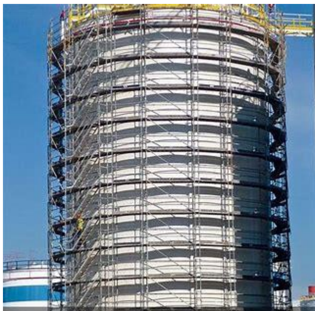
Figure 11.échafaudage en porte-à-faux
