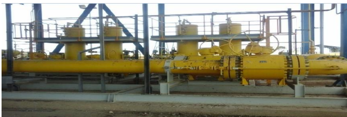
Figure III.4- les quatre filtres de poste gaz
