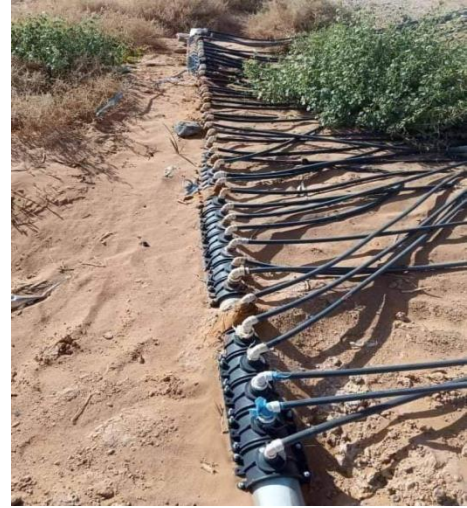
المصدر: صورة لأحد أعيان المنطقة 2020
