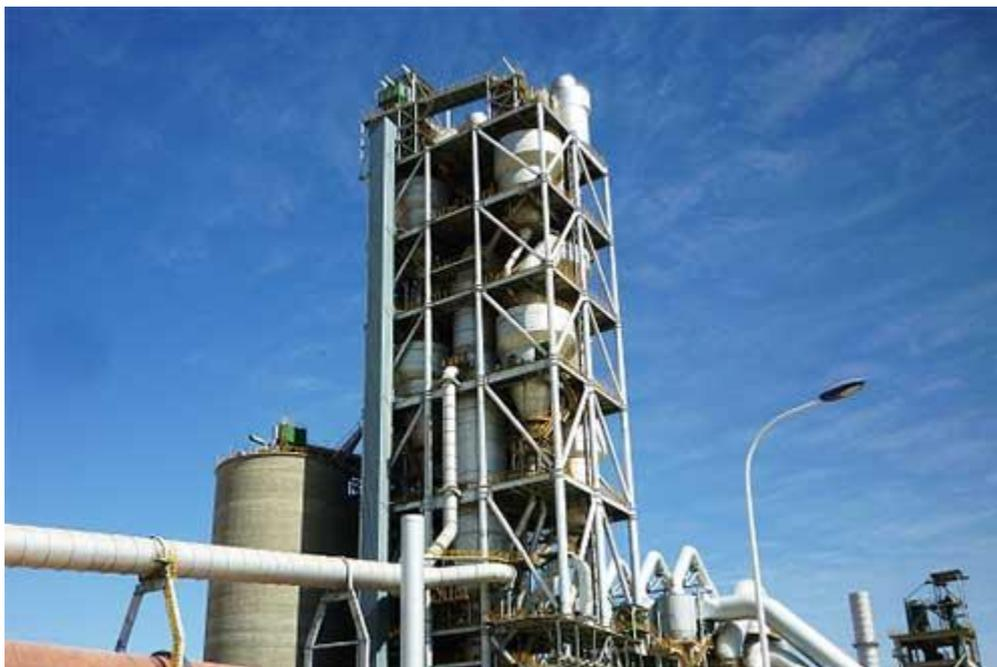
**Figure (1.12) : préchauffage**
