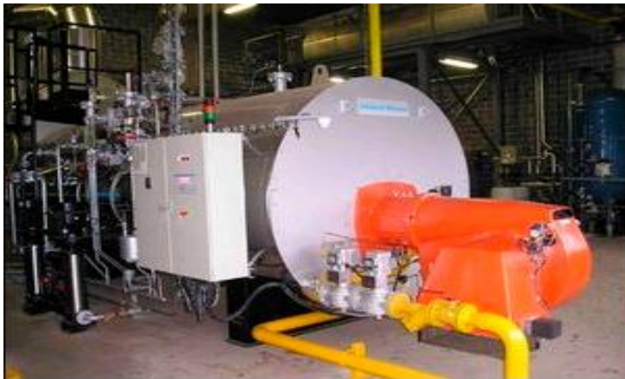
Figure III.3. Chaudière à vapeur.
