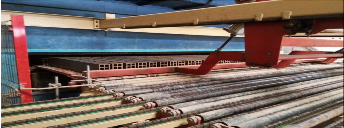
Figure 1.9 : Entrée de Séchoire (tunnels continus).
