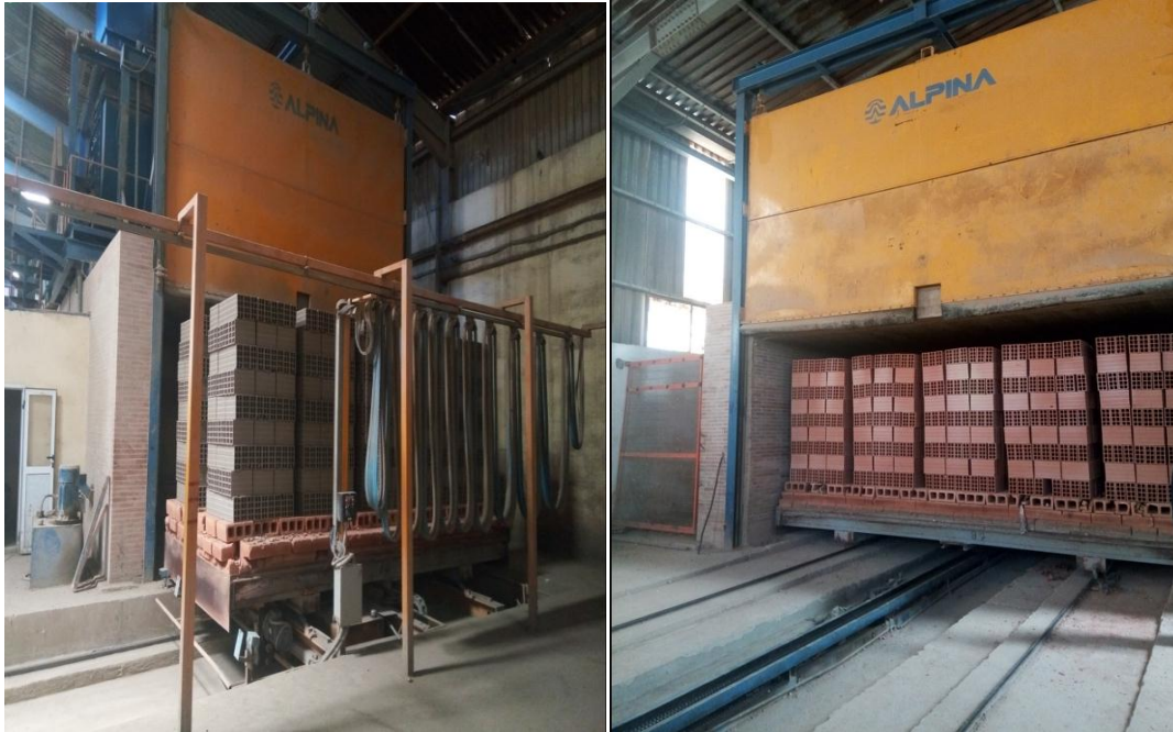
Figure 1.11 : Four tunnel (l'Entrée et la sortie).
