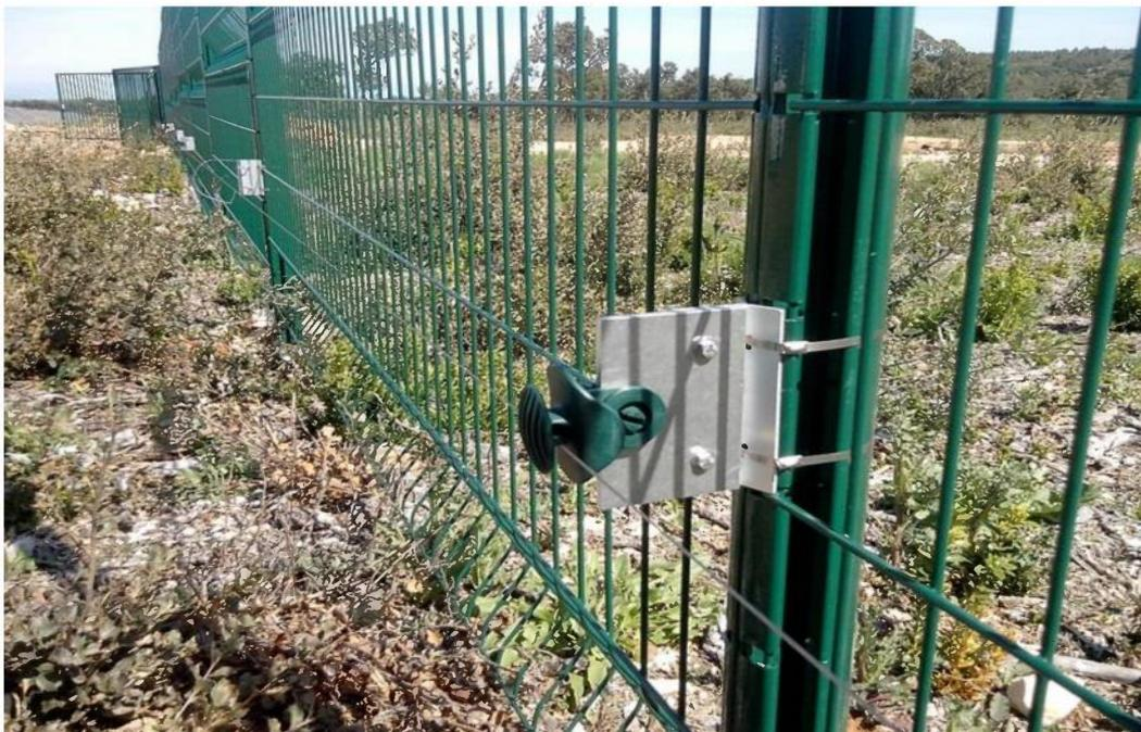
**Figure 3-17-** Exemple d'une détection par câbles
