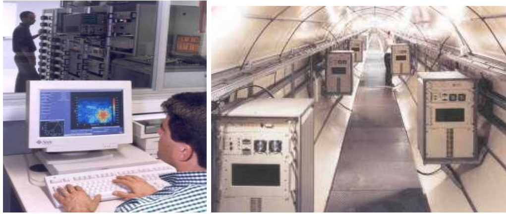
Figure I.19 : Salle de commande et réseau sous- terrain NOSTRADAMUS
