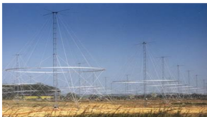
Figure I.18 : Implantation d'un réseau d'antennes transhorizon, base Nostradamus.
