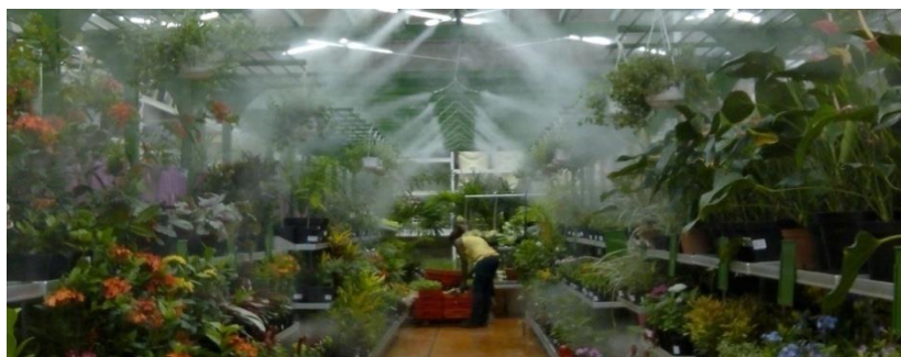
Figure I.24: Arrosage par brumisation pour serre.
