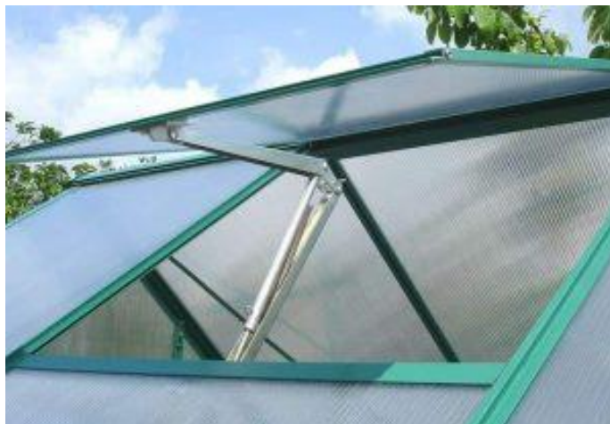
Figure I.10: Ventilation par ouverture d'une fenêtre automatique.
