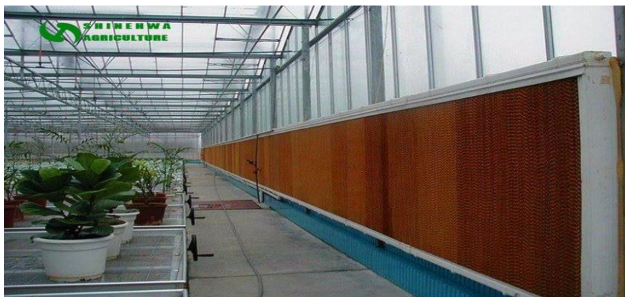
Figure I.15: Refroidissement de serre agricole avec cooling pad.
