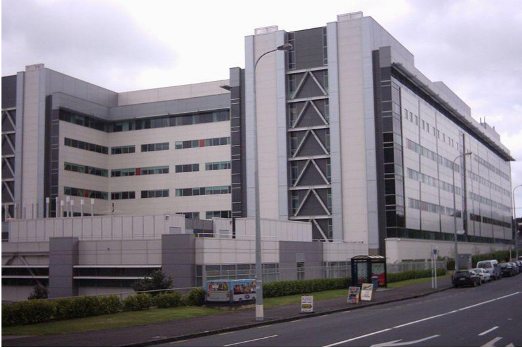
Figure 15: Hôpital de la ville d'Auckland - Auckland City Hospital
