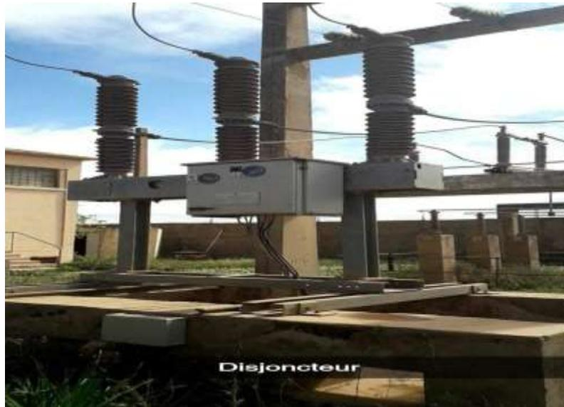
Figure I.13 : Photo réelle d'un disjoncteur
