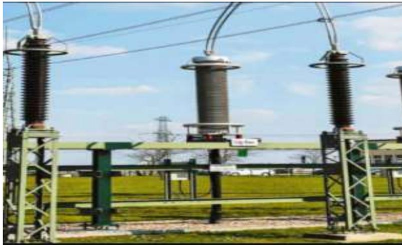
Figure I.12 : Parafoudre d'un poste électrique [20]
