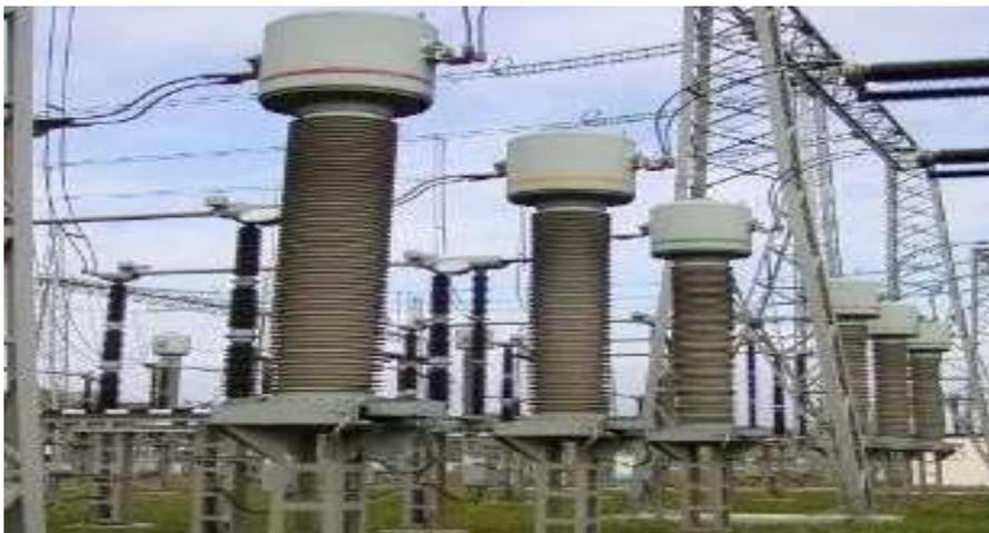
Figure I.16 : Transformateurs de mesure [18]
