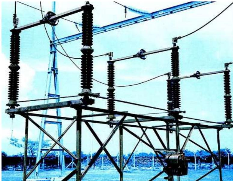
Figure I.14 : sectionneur d'un poste électrique
