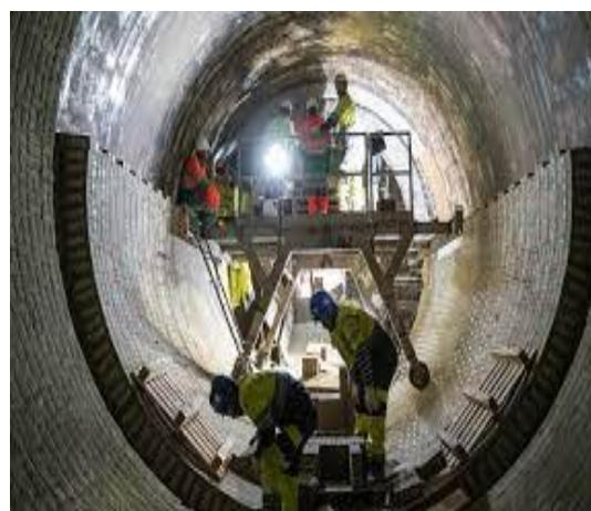
**Figures I.7 : Briquetage dans un four rotatif de cimenterie.**
