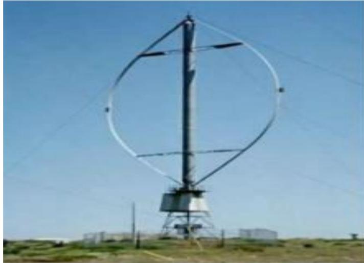
*Figure I.10 : Éolienne de Darrieus..*
