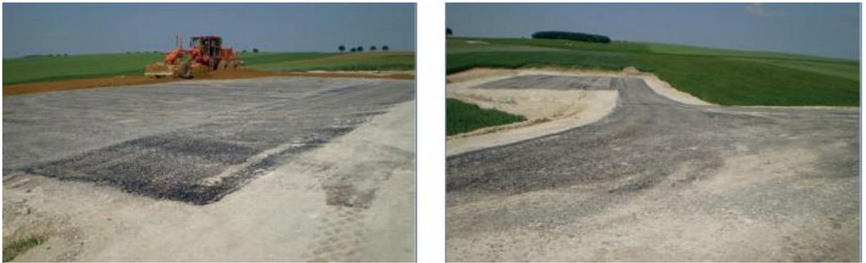
Figure III.6: Aménagement des plateformes de grutage.
