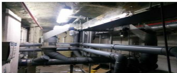
Figure II-17 Système pneumatique Aerocom
