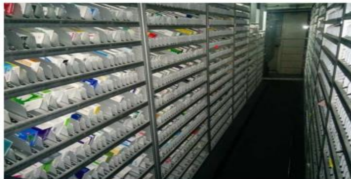
Figure II-16 Vue intérieure du système PHARMAX
