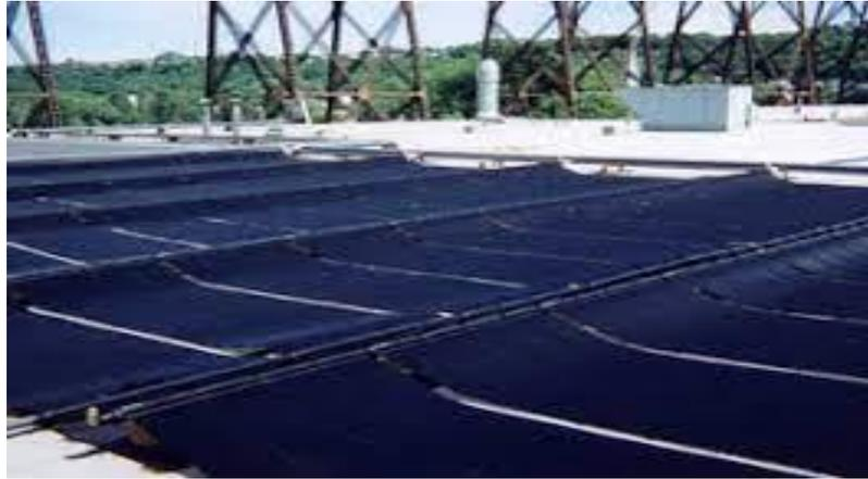
Figure II.4 : Capteurs plans sans vitrage.
