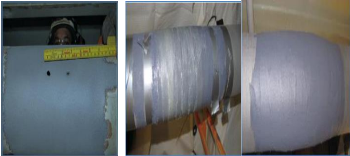
Figure I:5 Réparation par patch en composite d'une pipe acier[16]
