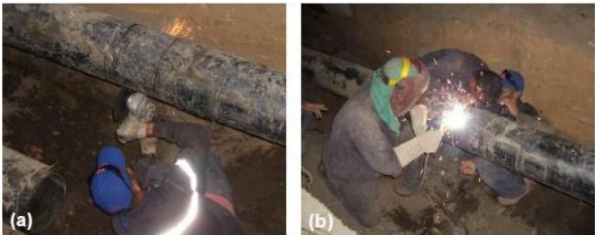
Figure I:10 Changement du tronçon endommagé d'une canalisation.(a) découpe/ (b) soudage
