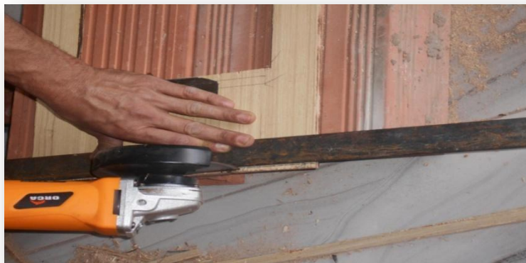
Figure III.33: Photo réelle de la découpe de la feuille multiplis
