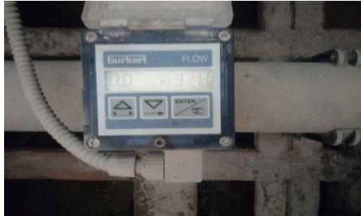
Figure1.26 Débitmètre électromagnétique
