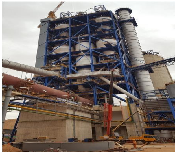
Figure 1.8 : Tour de préchauffage [3]
