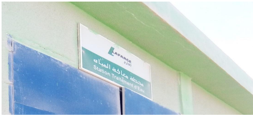
Figure 1.13 : Station traitement des eaux usée - LAFARGE
