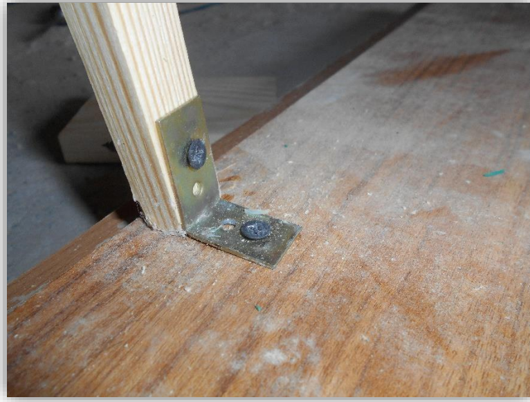
Figure III.35 : Photo réelle du support vertical fixé sur la base du bois rouge
