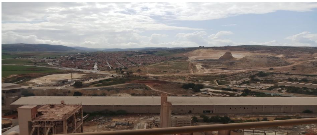
Figure II.5: Le carrière du calcaire et l'argile de l'usine Zahana.
