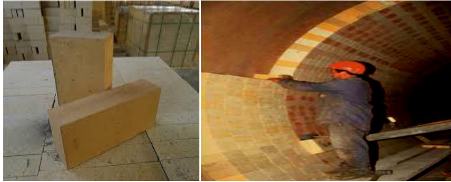
Figure I.9 : Briquetage dans un four rotatif de cimenterie.
