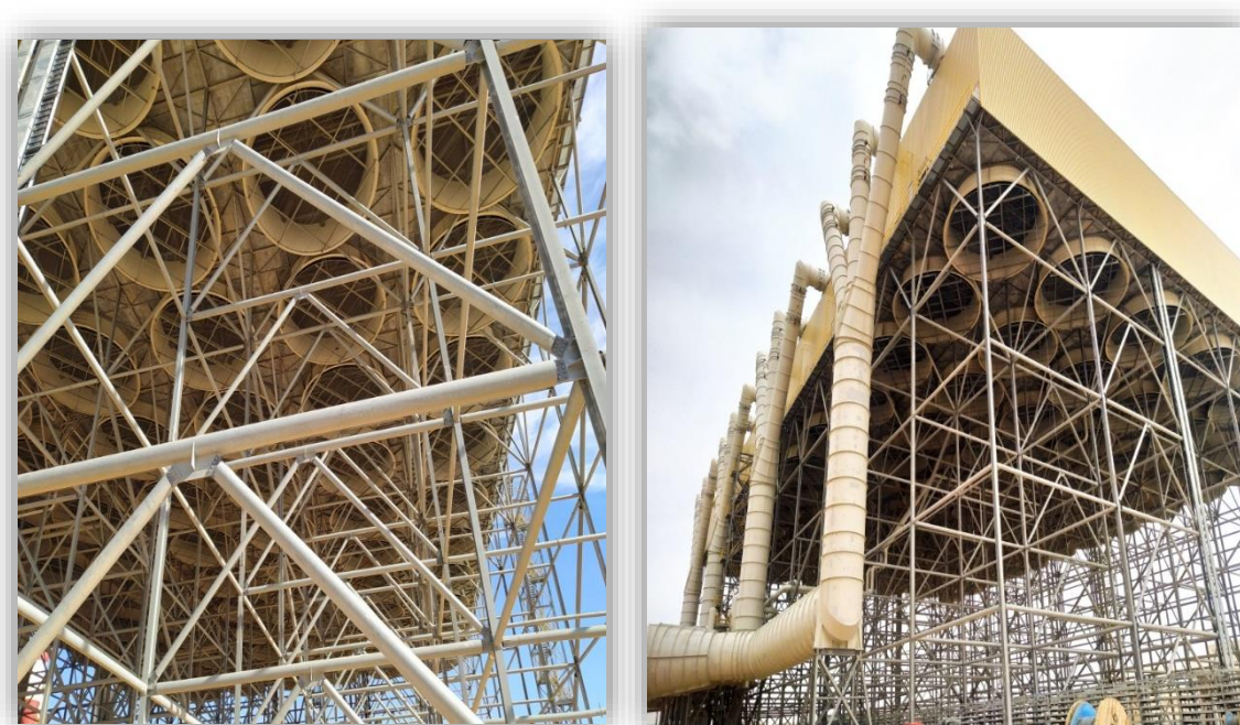
Figure 3.10 : Aérocondenseur [13]
