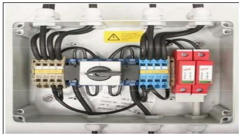
Figure III.44 : Exemple de boîte de jonction et câblage [80]
