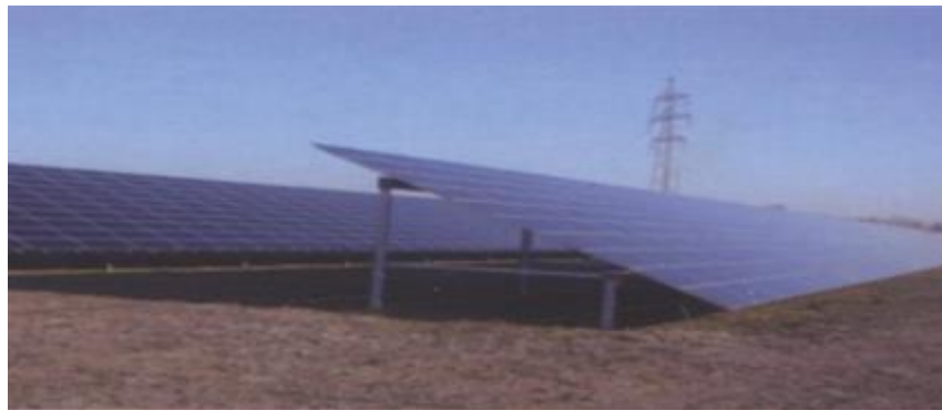
Figure 1.6 : Centrale PV au sol (Narbonne –Aude) [19]
