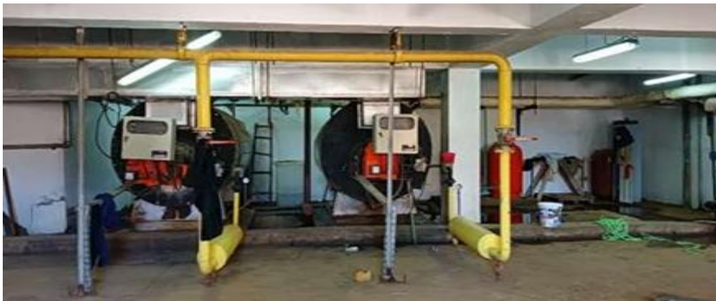
Figure I.6 : local technique extérieur.
