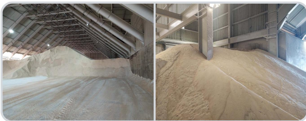
Figure I. 5 Hangar de stockage de sucre brut (roux) ( zone 02)
