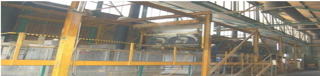
Figure Erreur ! Il n'y a pas de texte répondant à ce style dans ce document. -5:les bains de phosphatage
