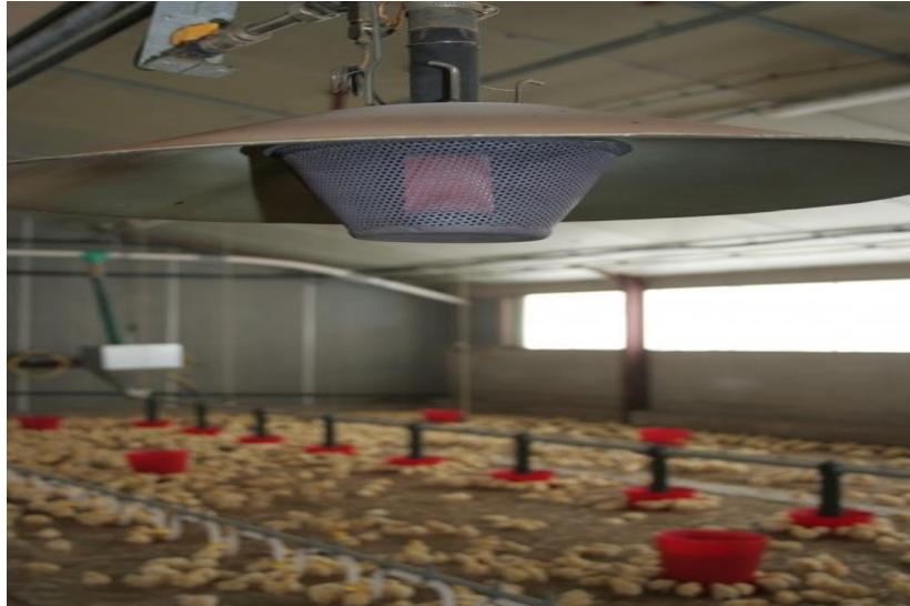
Figure I-2 Le chauffage (radiant à gaz).
